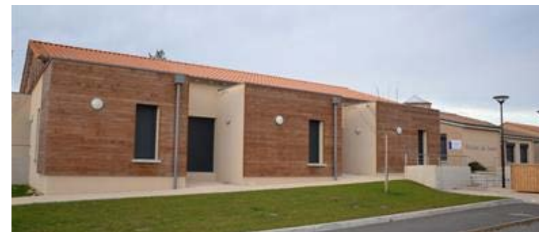
Maison de santé de Ménigoute (Financement DETR et FNADT)
